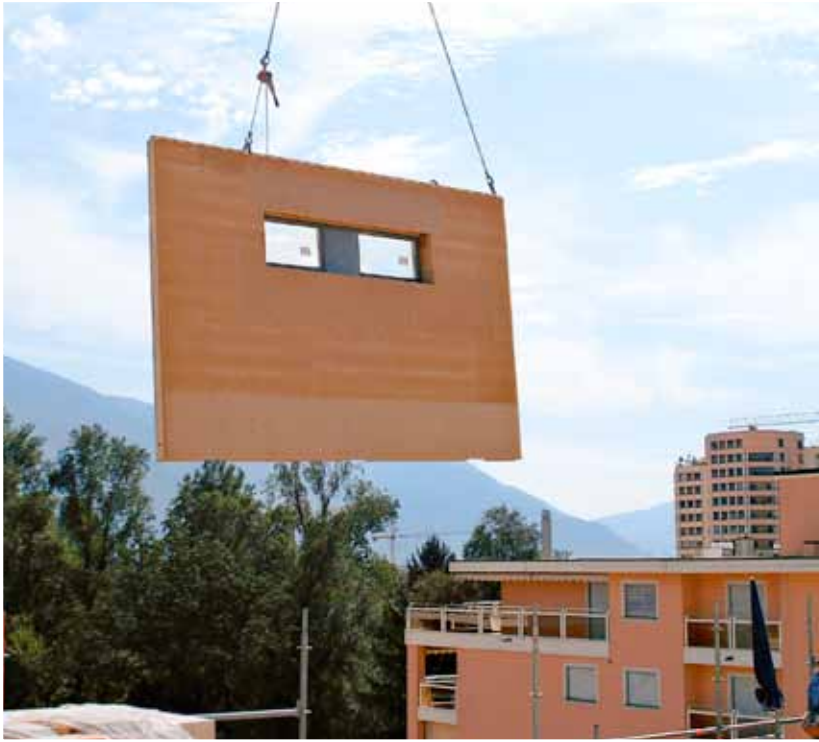
Montage vorgefertigter Bauteile
